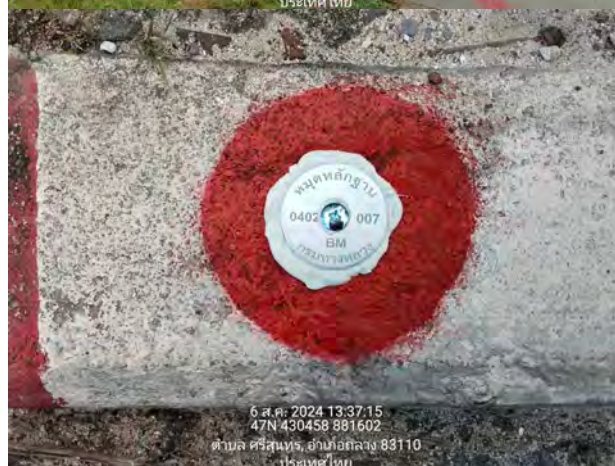
รูปที่ 4.3-2 ตัวอย่างการรังวัดเพื่อทำหมุดหลักฐานสำหรับการสำรวจข้อมูล
